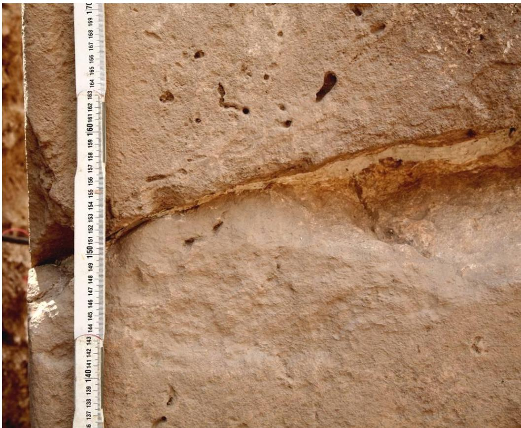
Auch wenn die Kanten der Fuge beim Sturz vor einigen tausend Jahren ausgebrochen sind, ist es möglich, die beiden Teile des Pfeilers, unter Berücksichtigung der erforderlichen Stärke des Klebers, millimetergenau zusammenzufügen.
