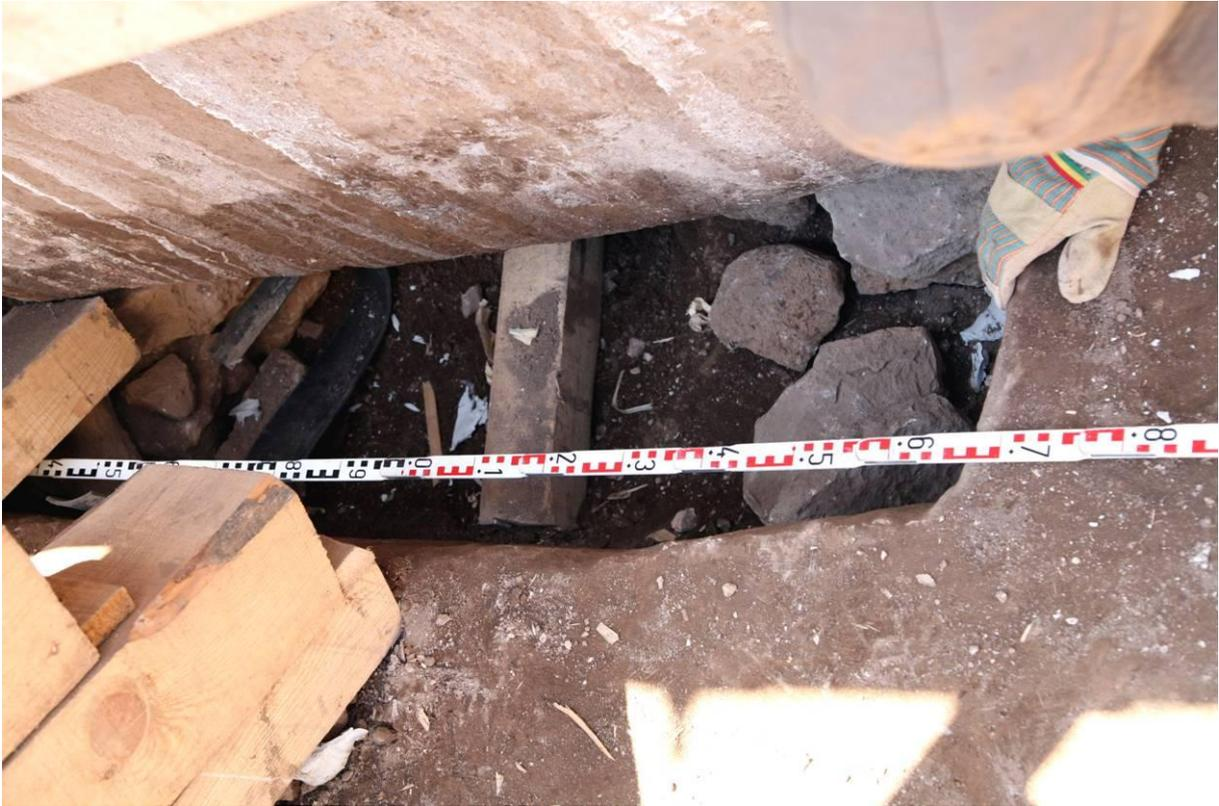
Nach Ausbau der Führungshölzer aus dem Köcher beginnt das Verkeilen mit Steinen. Nur das Kantholz unter der Mitte des Pfeilers verbleibt als Neuteil im Köcher, um die genaue Höhenlage des Pfeilers nach Befund zu erreichen. Nach dem Verkeilen mit Steinen wird das Kantholz in den nächsten Jahren verrotten, die Steine übernehmen alle Pfeilerlasten.
