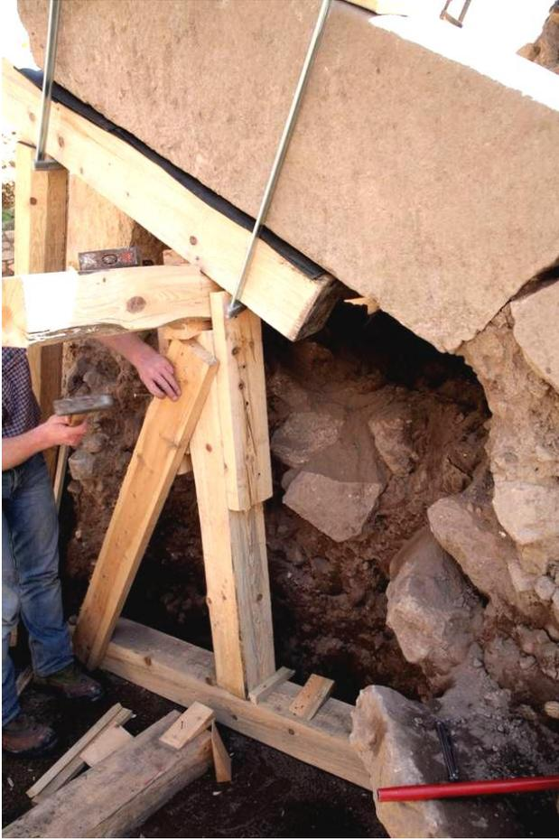
Unter den Schwerpunkt des Oberteils des Pfeilerschaftes wird eine Schwelle eingeschoben und zusätzlich unterstützt. Über diese Schwelle soll der Stein in eine waagerechte Position gekippt werden.
