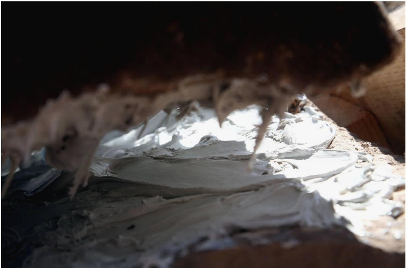
Fuge zwischen beiden Steinhälften mit dem auf beiden Kontaktflächen dick aufgespachtelten Kleber
