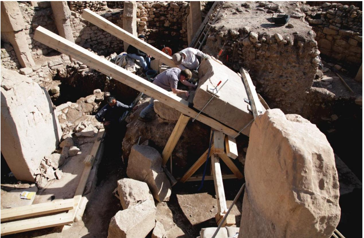
Die unter dem Stein vormontierten Hebel werden mit Gewindestangen mit den auf der Oberseite des Steins aufliegenden Kanthölzern verbunden. Mit der Vorspannung durch die Gewindestangen werden die Hölzer fest an den Stein gepresst. (Spange)
