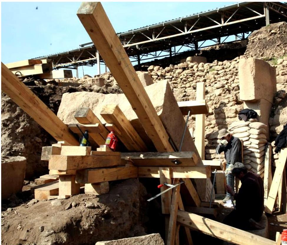
**06. April 2009** Am Tag nach dem Verkleben der beiden Hälften wird der zusammengefügte Pfeiler mit zusätzlichen Kanthölzern an der Unterseite, sowie einer dritten Spange an der unteren Pfeilerhälfte gesichert, um die Klebefuge beim Aufrichten nicht unnötig zu belasten.
