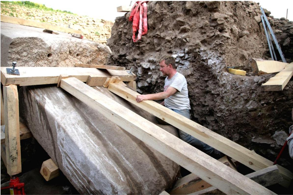
Einschwenken des oberen Bruchstückes vor das gesicherte untere Bruchstück.
