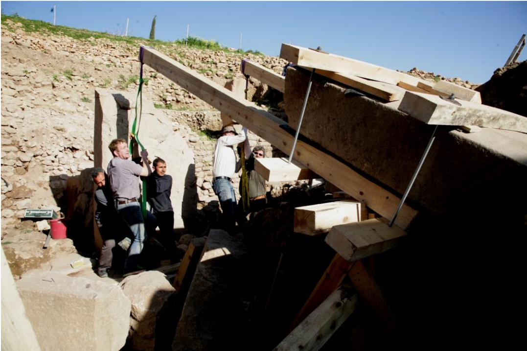
Rechnerisch sind ca. 400 kg (4 kN) erforderlich, um das Steinoberteil über die Schwelle in eine horizontale Lage zu kippen.
