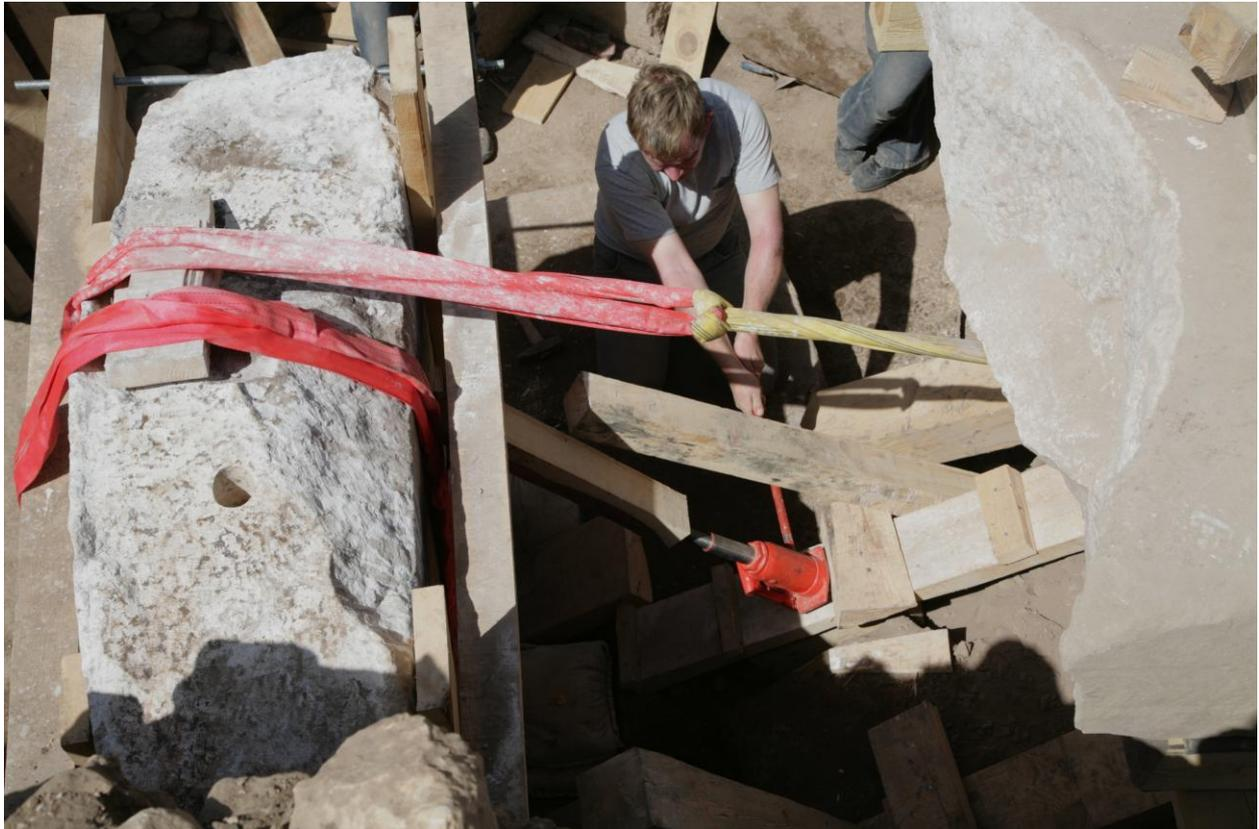
Langsames Zurückziehen des Pfeilerunterteils per Kettenzug und Wagenheber Richtung Osten in eine Position, die das Zusammenfügen mit dem Oberteil ermöglichen wird
