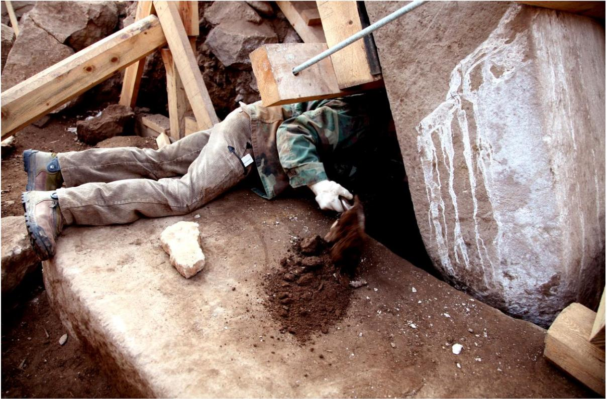
**07. April 2009** Vor der endgültigen Fixierung im Köcher werden die letzten Reste geplatztter Sandsäcke und nachgerutschtes Erdmaterial aus dem Köcher entfernt.
