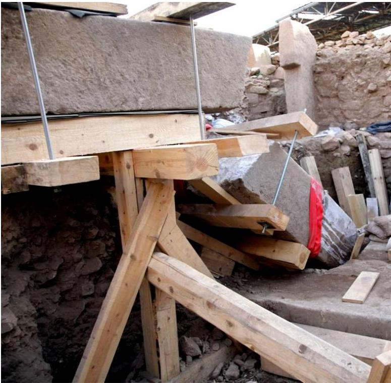
Das für die Verklebung im richtigen Winkel ausgerichtete Pfeilerunterteil.
