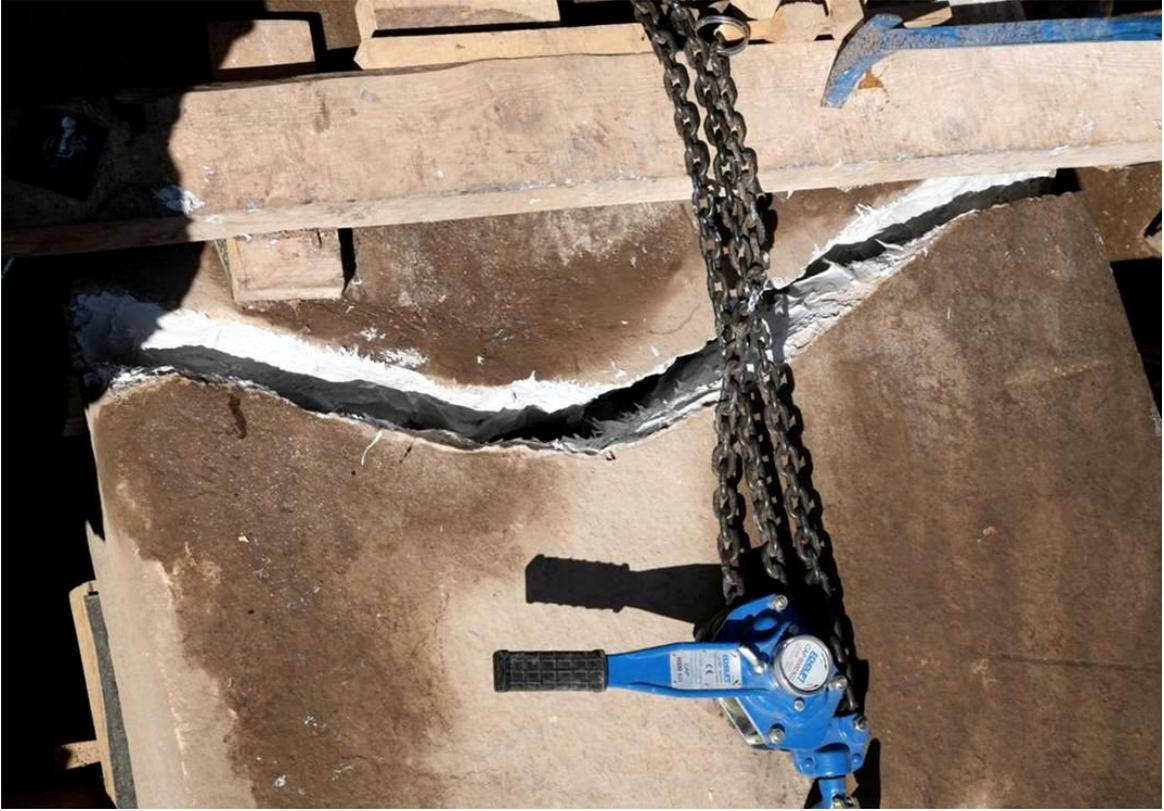
Fertig zum Zusammenziehen der beiden Schafftteile Um Verunreinigungen durch den Kleber auf den Sichtseiten des Pfeilers zu vermeiden, wird die Steinoberfläche entlang der Fuge mit einer feuchten Lehmschicht überzogen
