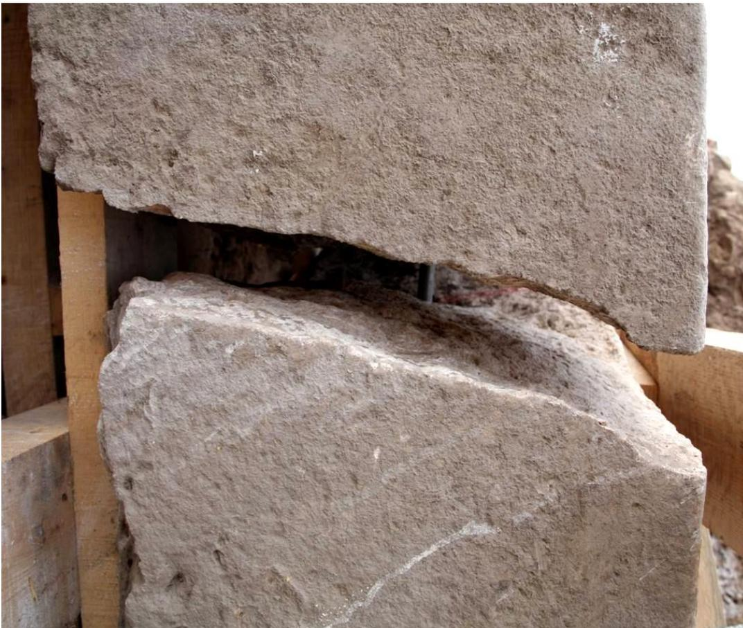
Fuge zwischen Ober – und Unterteil nach dem genauen Ausrichten vor Auftragung des Klebers.
