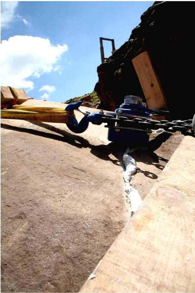
Die beiden Teile des Pfeilers sind zusammengefügt. Der überschüssige Kleber wird unter der Zugkraft des Kettenzugs herausgedrückt.
