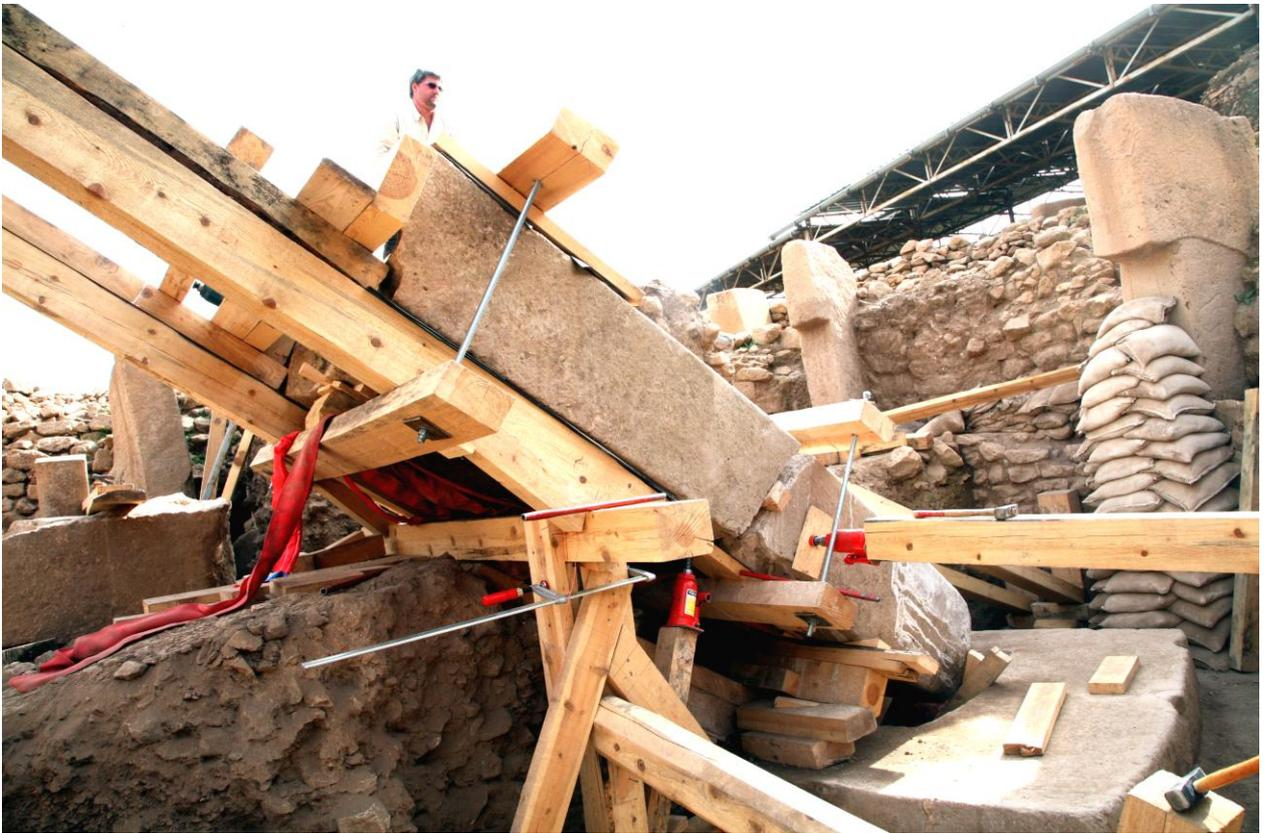
Exakte Ausrichtung der Teile, auch mit horizontaler Sicherung gegen Verrutschen und Verschieben.
