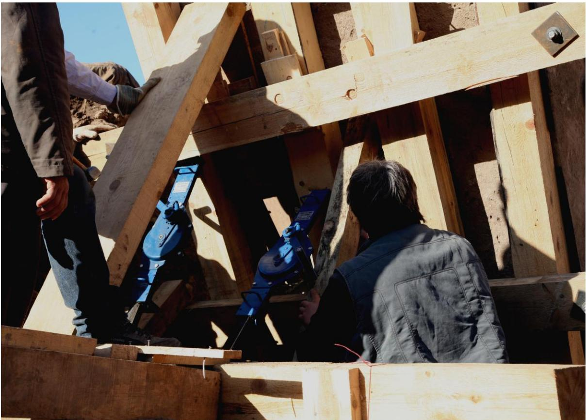
Mit zunehmender Aufrichtung und den damit verbundenen geringeren Lasten war es möglich, den Pfeiler mit den Fußwinden zu bewegen.
