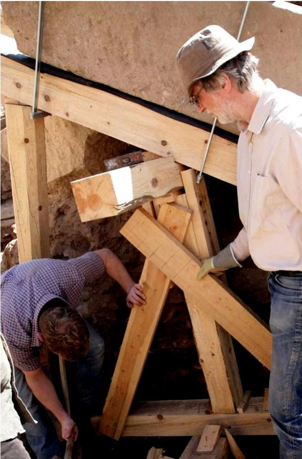
Das Auflager der Schwelle wird gegen Verschiebungen gesichert
