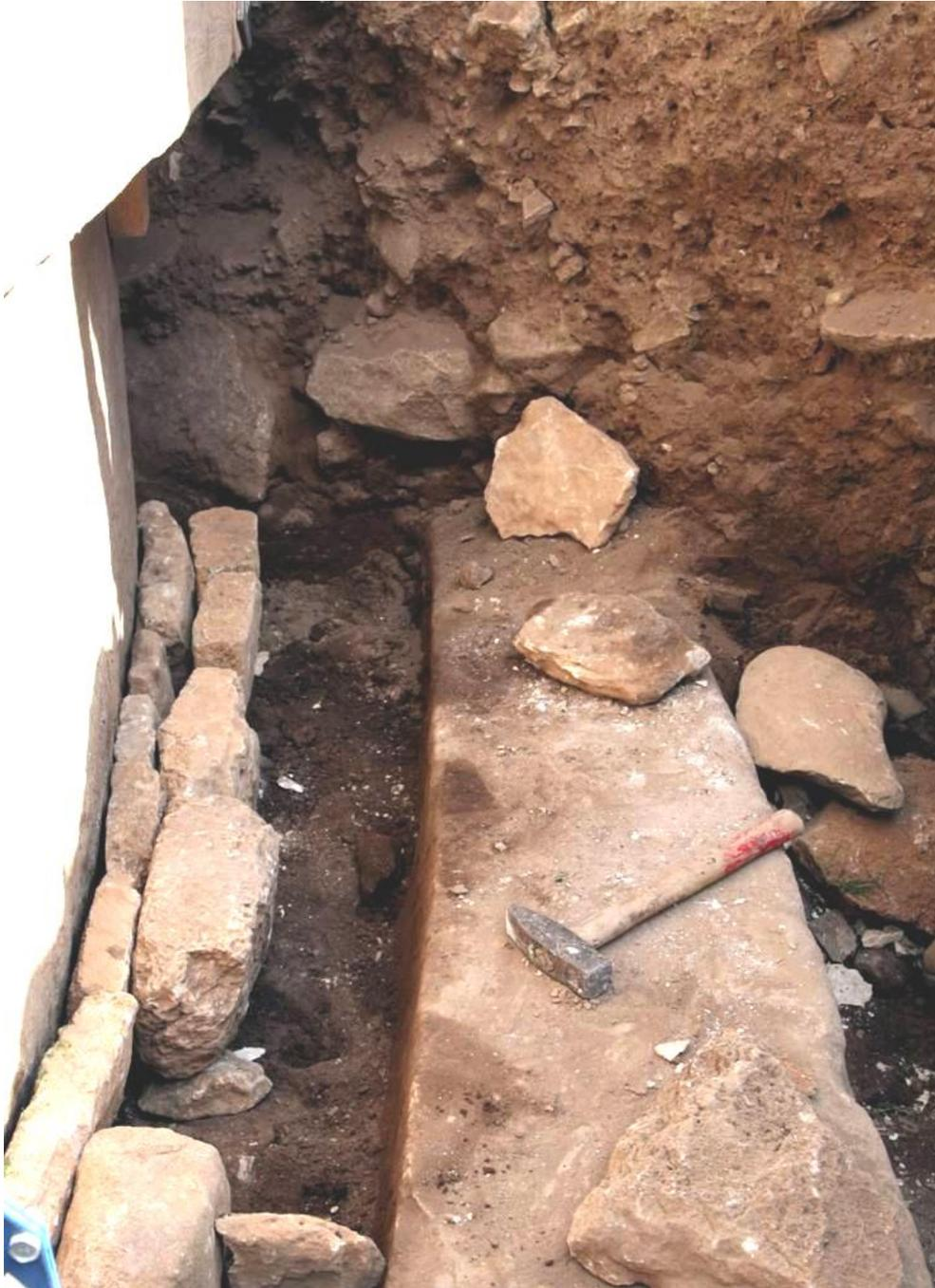
Die Steine werden lagenweise in den Köcher eingebaut und mit gesiebter Erde eingeschlämmt, um die Hohlräume zwischen den Steinen zu schließen.
