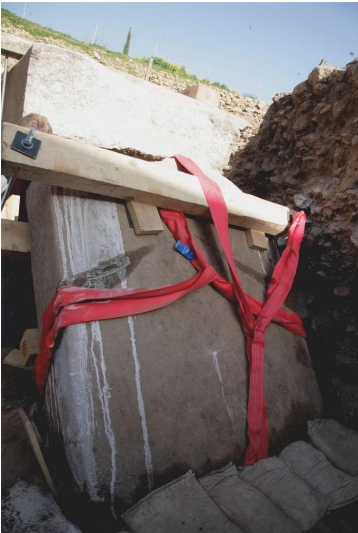
Zur horizontalen Sicherung des Pfeilerfußes während der Ausrichtung werden Sandsäcke in den Köcher eingebracht. Ein Verutschen des abgerundeten Pfeilerfußes im Köcher wird somit verhindert.
