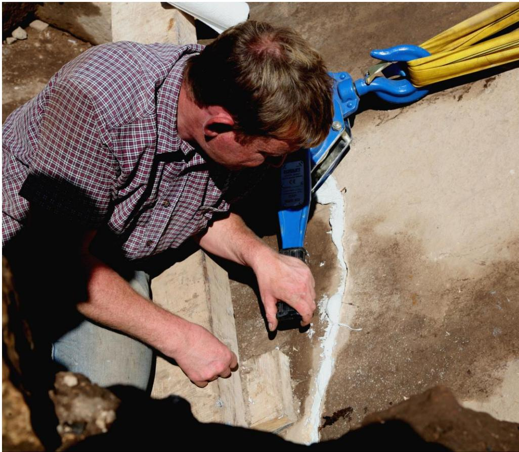
Während des Aufeinanderdrückens innerhalb der verfügbaren Reaktionszeit des Klebers von ca. 20- 30 Minuten müssen die Passungen zwischen beiden Teilen genau kontrolliert werden. Eine Unterbrechung des Vorgangs ist ausgeschlossen. Ein Versagen der Planung in der gegenwärtigen Phase hätte zur sofortigen Abreise der Verantwortlichen mit unbekanntem Ziel geführt.
