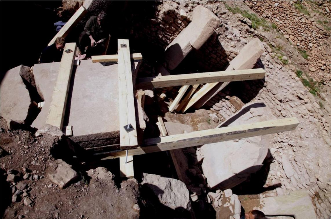
Nach Ausbau des Auflagersteines kann auch die zweite Spange zur Befestigung der Hebel montiert werden.
