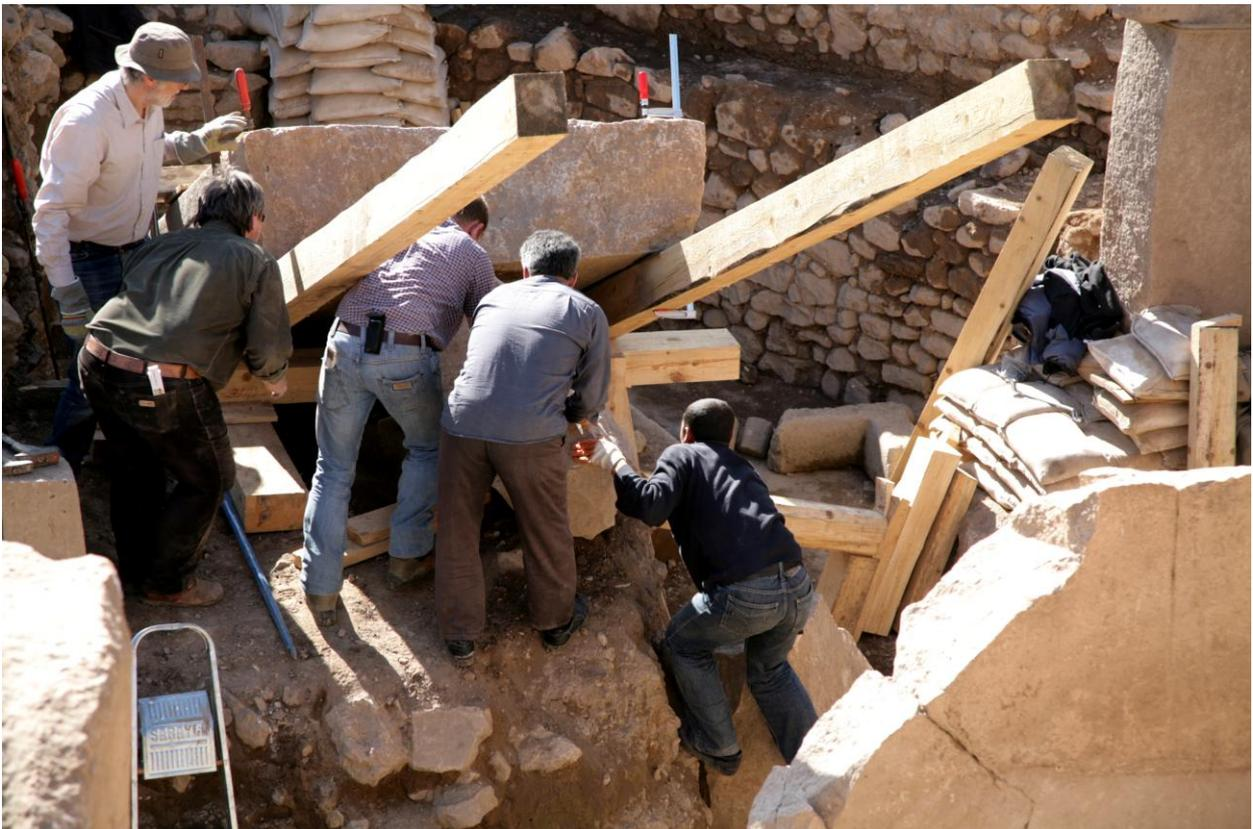
Der „Auflagersteine“ unter dem Pfeileroberteil muss für die Montage der zweiten, oberen Spange aus dem Weg geräumt werden. Um den Stein bewegen zu können wird das Pfeileroberteil mittels Wagenhebern leicht angehoben.
