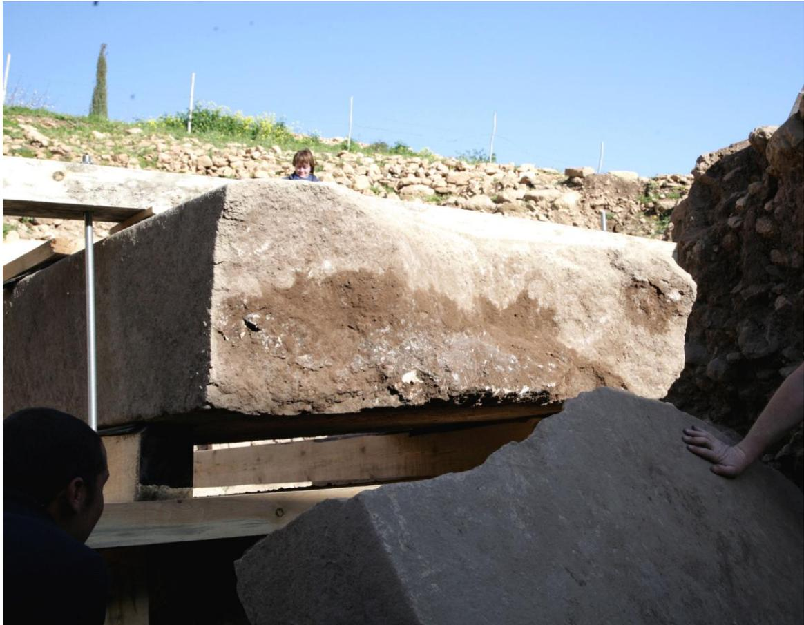
Jetzt waagrecht liegendes oberes Bruchstück mit der frei liegenden Bruchstelle, die waagerechte Kernbohrung kann erfolgen.
