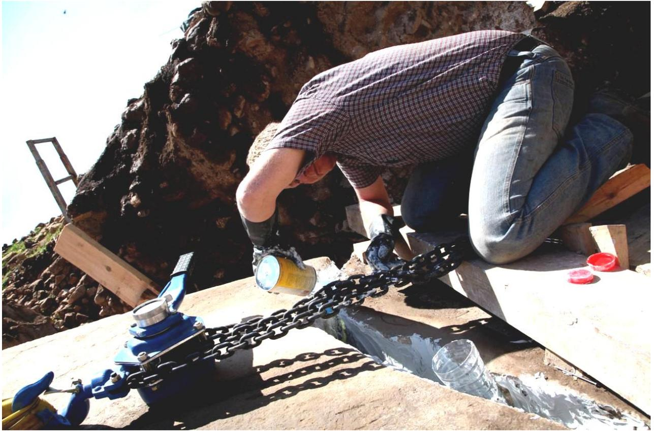
Wegen der stark begrenzten Zugänglichkeit werden die Dübel im unteren Teil des Pfeilers mit flüssigem Zweikomponenten- Epoxydharz ausgegossen. Aufgeschnittene Plastikflaschen dienen als Trichter.
